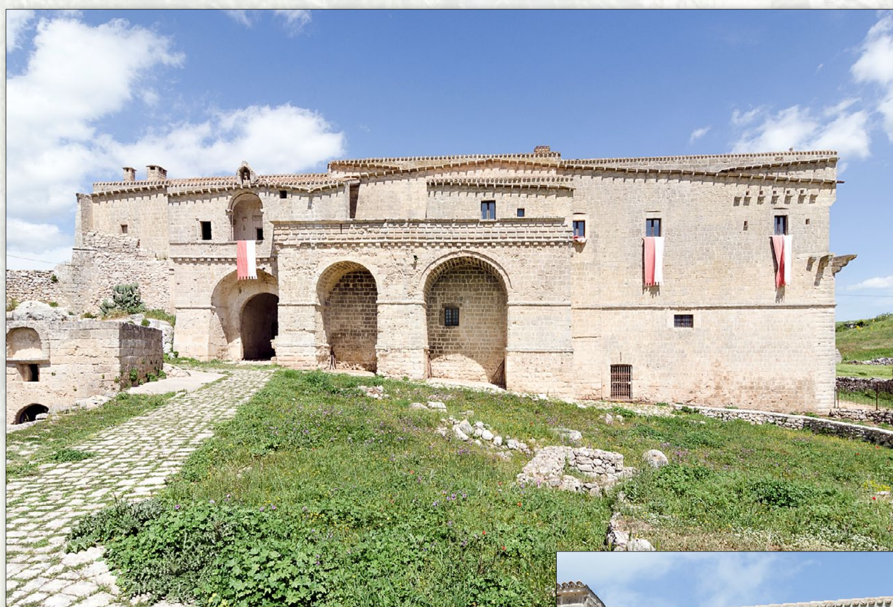
La poderosa facciata scandita dalle arcate.
